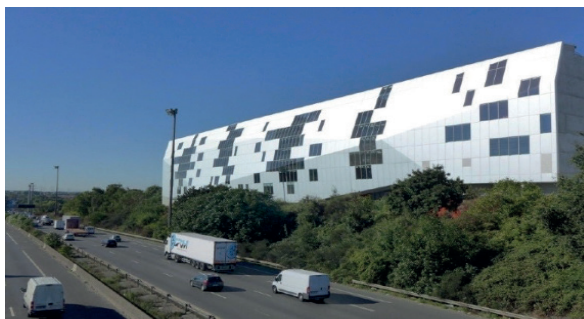
Le bâtiment écran de la ZAC La Cerisaie, face à l'A6. © A.L. Abraham.
